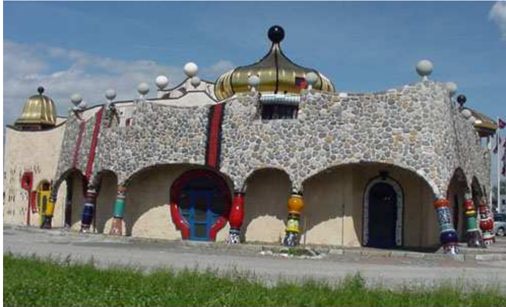
Blick von der Straße aus auf die Markthalle in Altenrhein
