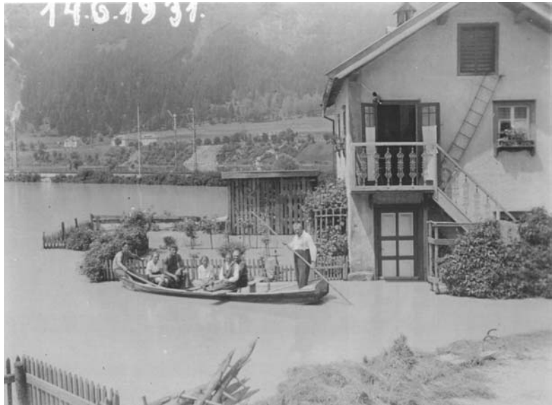
14.6.1931, Hochwasser hier beim Überführer 827
