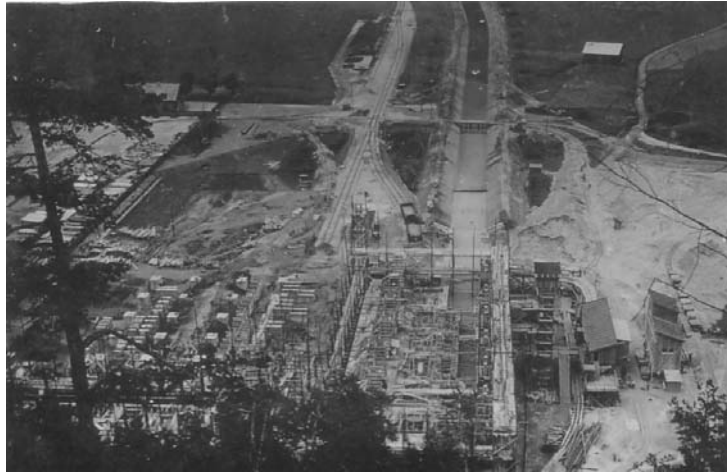
Tiwag-Kraftwerk: Bau der Turbinenhalle
