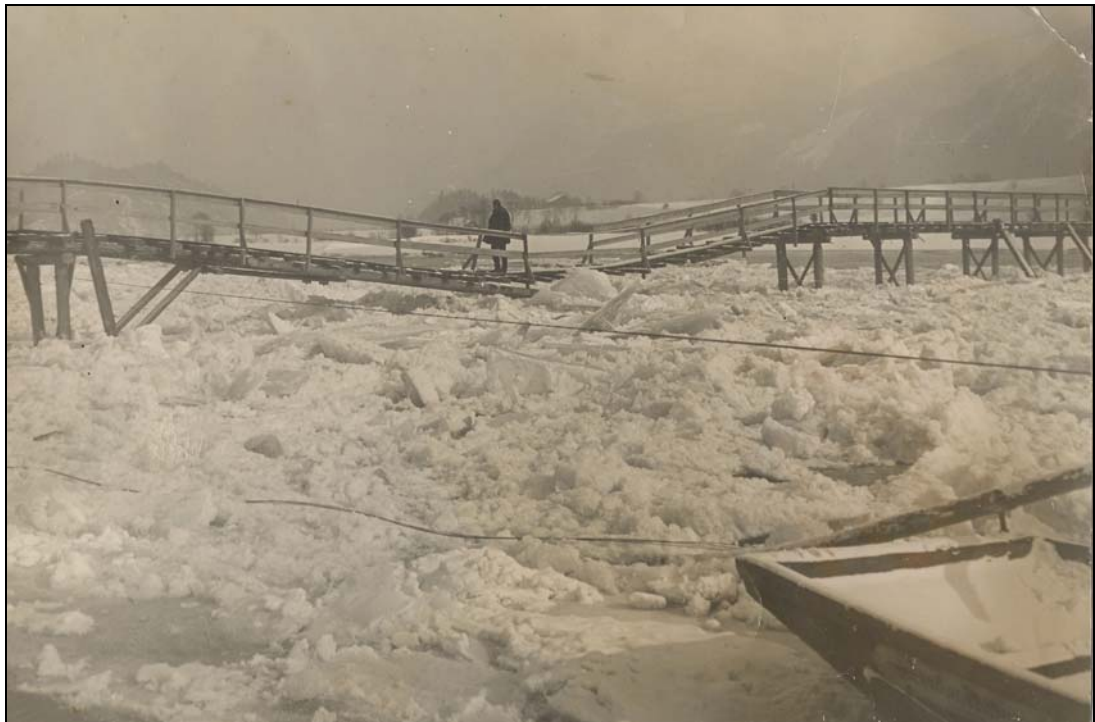
Der eingestürzte Innsteg am 22.12.1940 881
