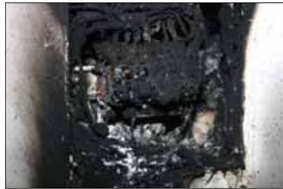
*Diese Unterverteiler brannten in den Wohnungen vom Erdgeschoss bis in den 6. Stock des Gebäudes.*
