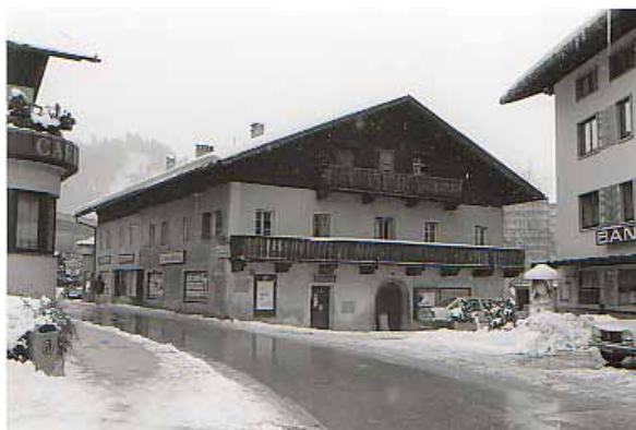
1989 kurz vor dem Abriss Fotos: Bestand Gemeindecarchiv
