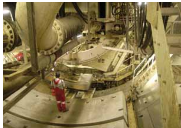
Einbau der Energietübbinge im Tunnellos H8 Jenbach
