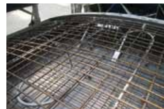
Herstellung des Energietübbings: Die Absorberleitungen (grau) werden an der Bewehrung befestigt.
