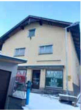
Ostansicht des Hauses kurz vor dem Abbruch Jänner 2024, Foto Bestand Monika Singer
