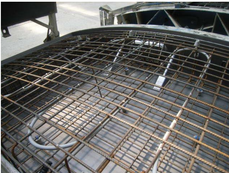
Abbildung 3: Herstellung des Energietübbings: Die Absorberleitungen (grau) werden an der Bewehrung befestigt.
