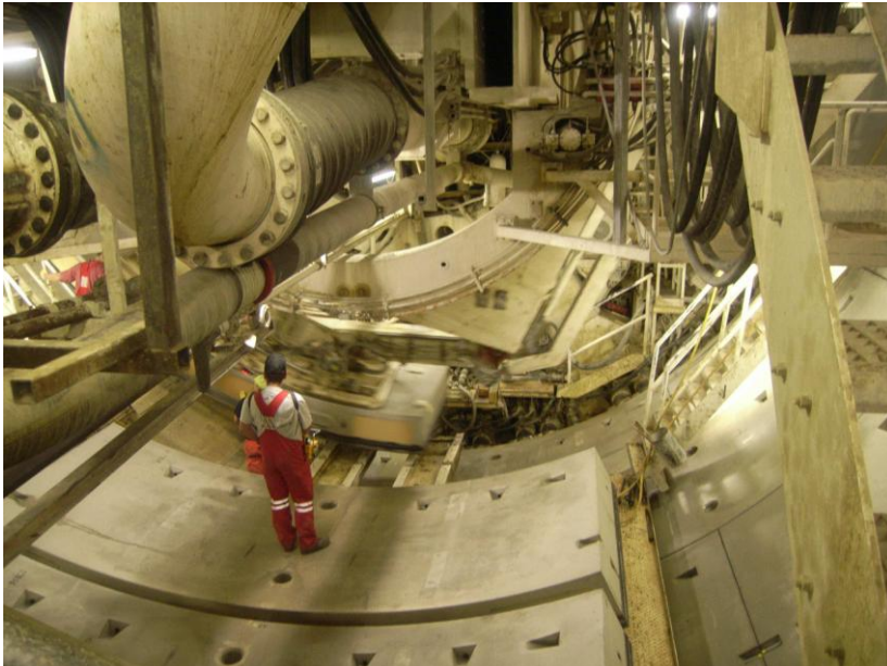
Abbildung 5: Einbau der Energietübbinge im Tunnelos H8 Jenbach
